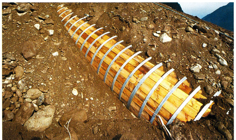
Bild 12. Holzdruckleitung.
