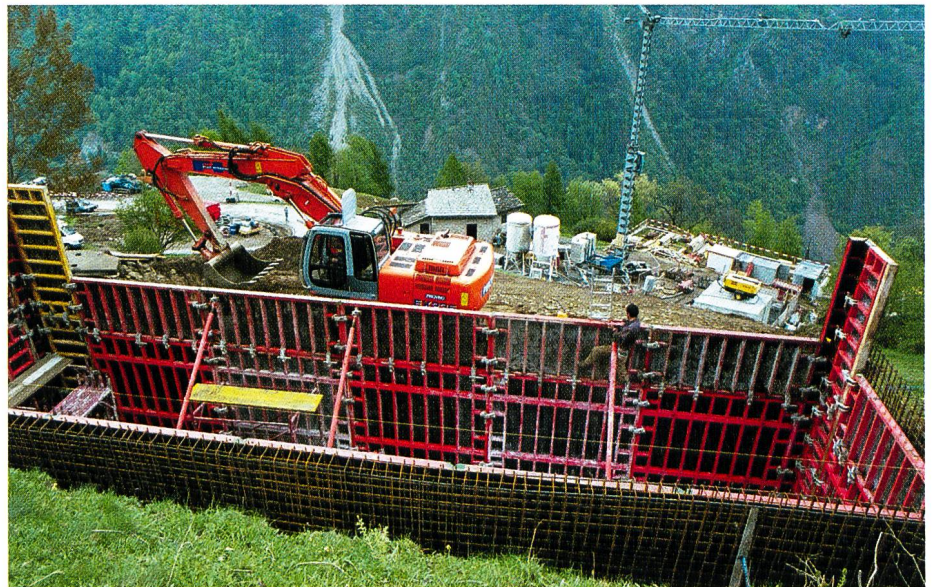
Bild 11. Bau der oberen Wasserschlosskammer.
