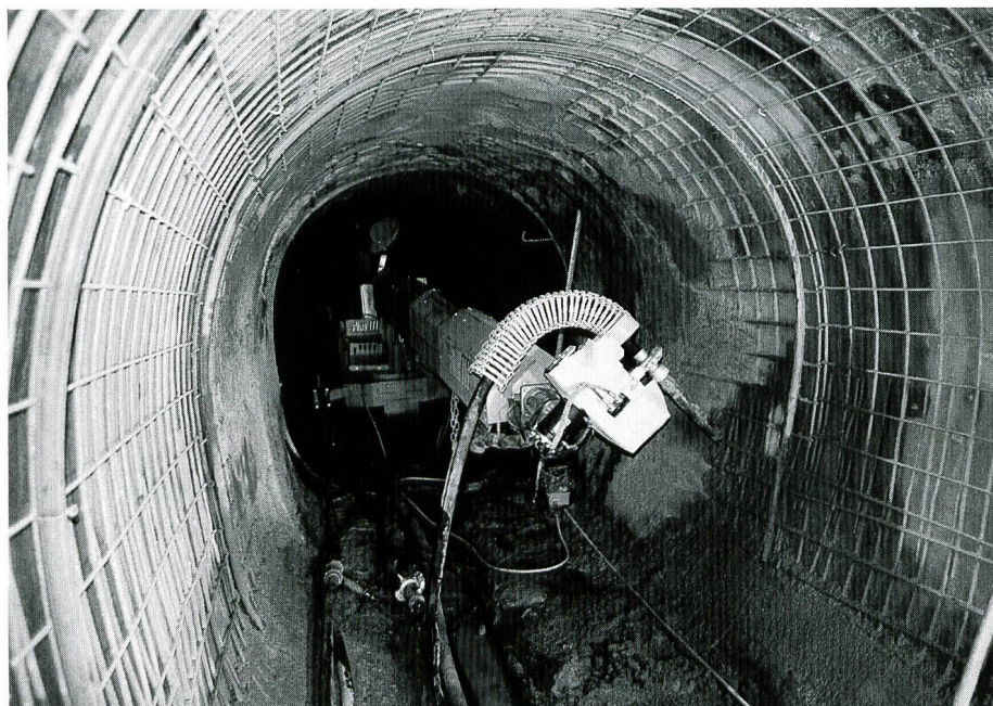
Bild 9. Einsatz von Spritzrobotern im Stollengewölbe.
