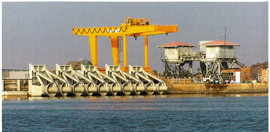
Bild 1. Fünf Hydromatrix®-Turbinenmodule und Dammkran des Kraftwerks Jebel Aulia.
