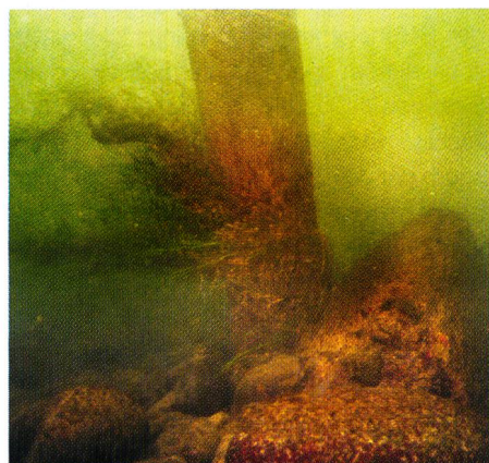
Bild 9. Unterwasseraufnahme der Überreste des linken Flügels des alten v-förmigen Klappenwehrs. Der Pfahl war ein Teil der Lagerung der 1,1 m hohen Stautafeln (vgl. Bild 1). Gut ersichtlich sind die Beton- und Steinblöcke des alten Grundwehrs (Bildquelle: Schwarz Taucherarbeiten AG, Dezember 2001).
