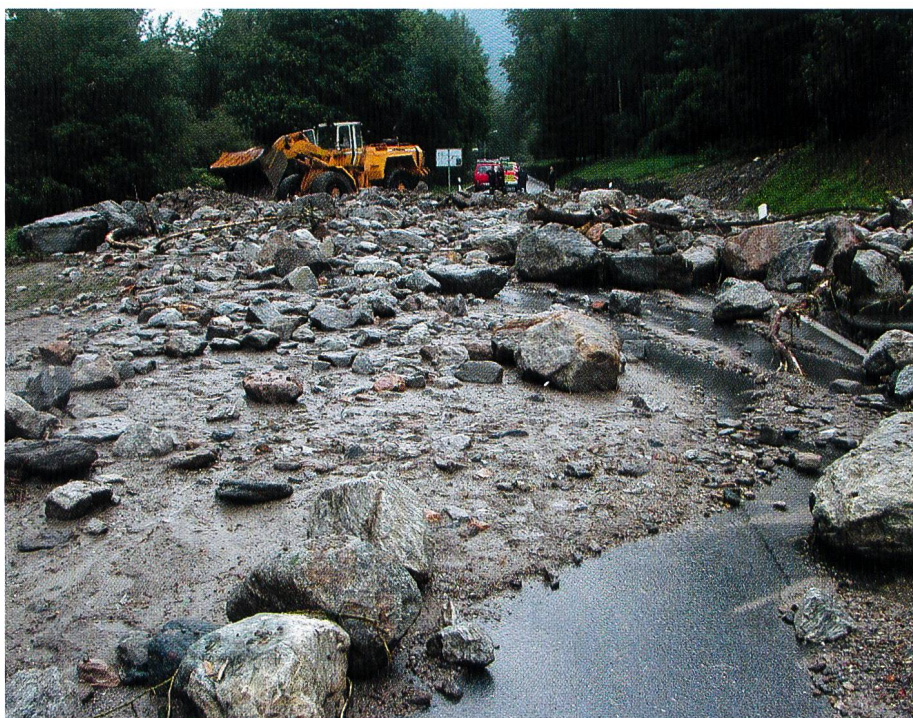
Bild 8. Überführte Strasse bei Lottigna TI (Bleniotal), 29. August (Bildquelle: Dipartimento del Territorio Cantone Ticino, Sezione Forestale).
