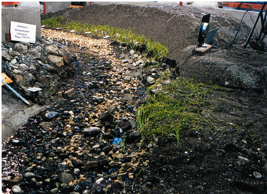
Bild 7. Uferschutz der Reuss bei Göschenen nach Belastung mit dem \text{EHQ} = 700 \text{ m}^3/\text{s} (VAW, 1994).
