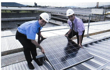
Sur le toit du Stade de Suisse Wankdorf Bern, Jakob Vollenweider, chef Communication Energie FMB (à gauche), et Martin Pfisterer, membre de la Direction du groupe FMB, posent le premier panneau de la plus grande centrale solaire au monde intégrée au toit d'un stade (Photo: Philipp Zinniker).
