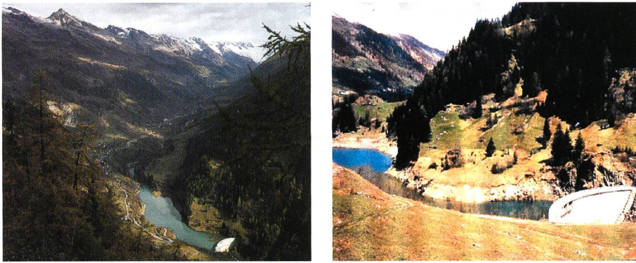
Bild 1. Bogenstaumauer mit Ausgleichsbecken Ferden.
