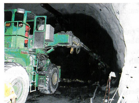
Bild 8. Bohrwagen beim Herstellen der Sprengbohrlöcher (Quelle: IGWS).
