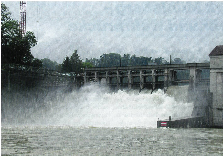
Bild 2. Das alte Wehr bei Q = \text{ca. } 460 \text{ m}^3/\text{s} , Brücke über Schiffsaufzug (links) bereits abgebrochen, breitere Öffnungen rechts = «KKM-Klappen».
