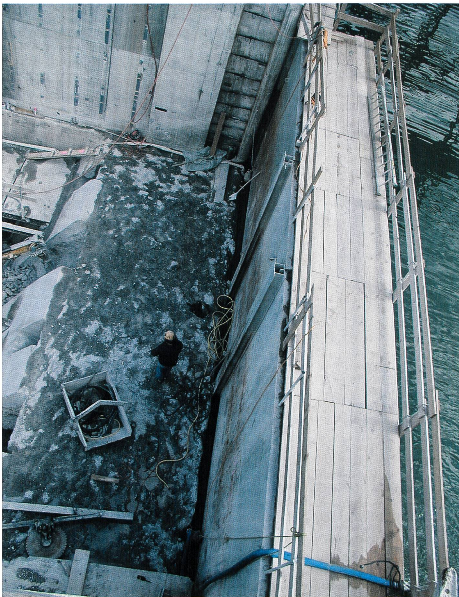
Bild 5. Blick auf den Senkkasten, rechts Oberwasser, links der zum Aufbetonieren der neuen Wehrschwelle abgetragene Wehrrücken.
