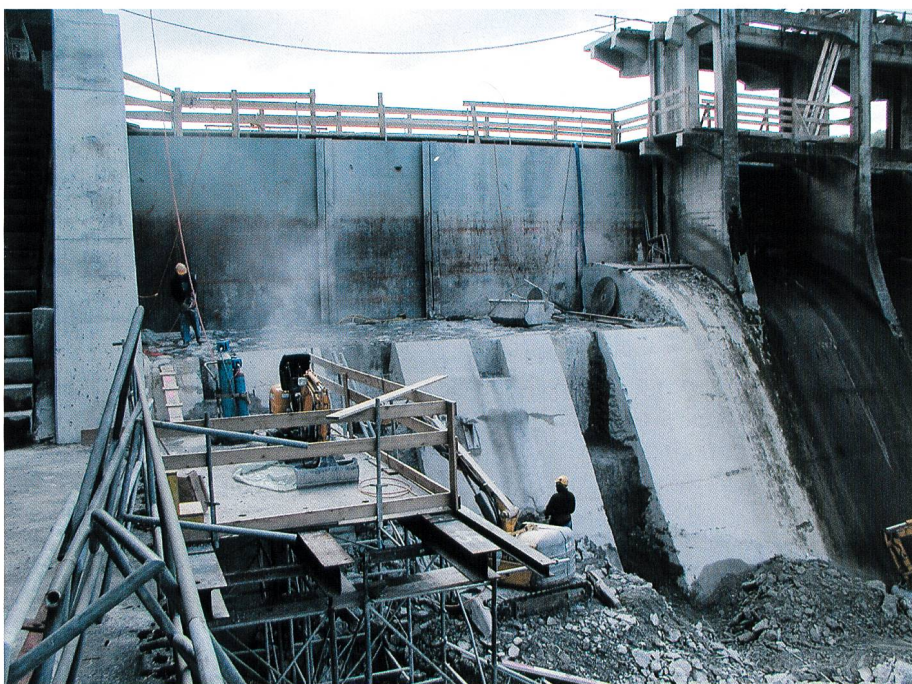
Bild 6. Abbrucharbeiten im Schutz des Senkkastens, rechts altes Wehr und Brücke.
