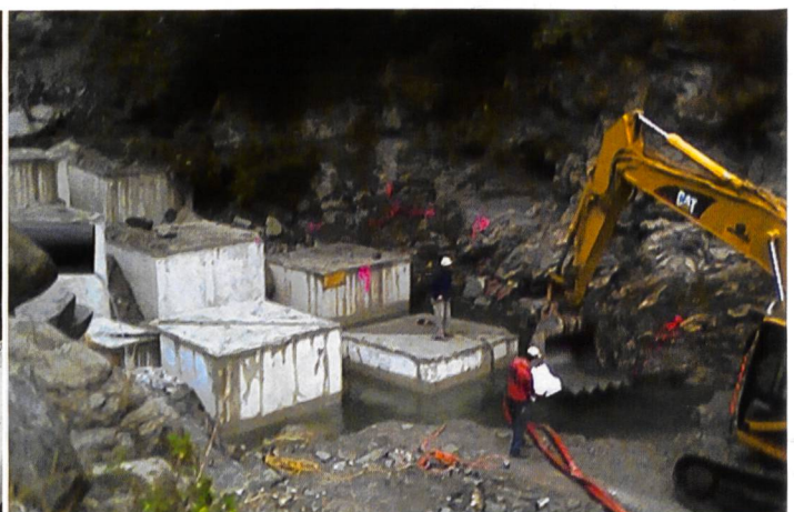
Bild 11. Links: Bau der Buhne vor dem Chemietank. Im Vordergrund eine platzierte, aber noch nicht ausbetonierte Hülle. Die Prismen sind rauteitig seitlich versetzt. Rechts: Bau der Blockrampe unterhalb der bestehenden Fassung. Betonwürfel werden im Bachbett versetzt und anschliessend überdeckt.
