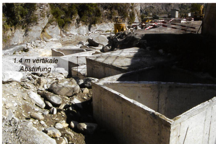
Bild 11. Links: Bau der Buhne vor dem Chemietank. Im Vordergrund eine platzierte, aber noch nicht ausbetonierte Hülle. Die Prismen sind rauteitig seitlich versetzt. Rechts: Bau der Blockrampe unterhalb der bestehenden Fassung. Betonwürfel werden im Bachbett versetzt und anschliessend überdeckt.
