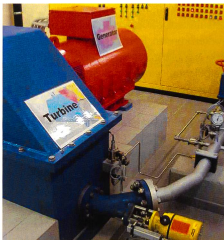
Bild 3. Mit der 300-kW-Turbine und dem angeschlossenen Generator werden jährlich über 1 Mio. kWh Ökostrom produziert.
