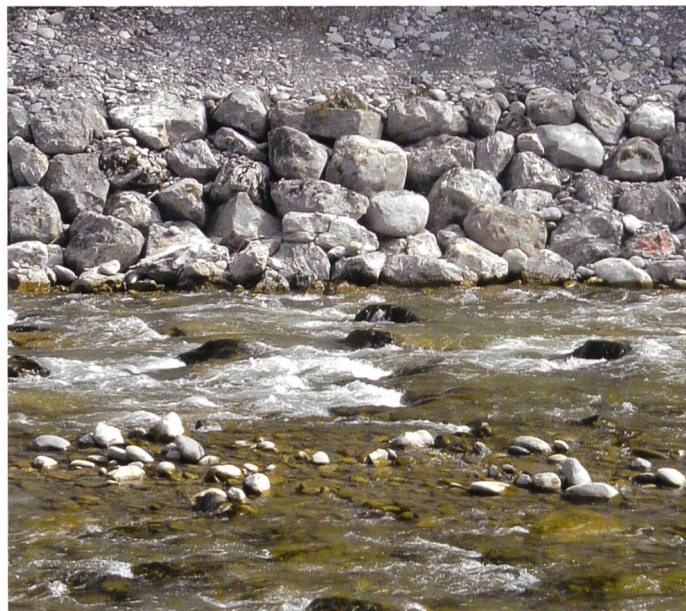
Bild 22. Naturnahe Sohlenstruktur auf der Blockrampe nach Auswaschen der Feinanteile aus der Überschüttung.
