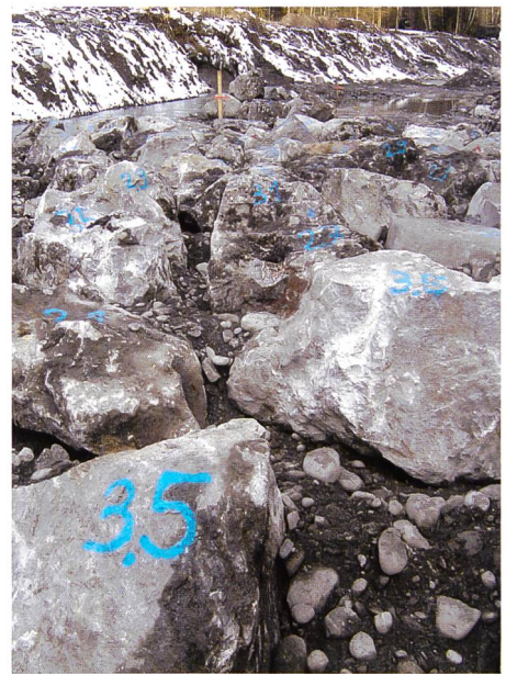
Bild 18. Bauüberwachung und Qualitätssicherung, angeschriebene Massen auf Einzelblöcken.
