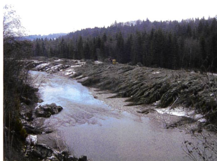
Bild 2. Abholzungen im Bereich der rechtsseitigen Aufweitungen.
