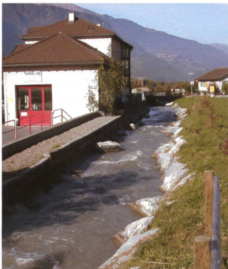
Bild 1. Einen Teilbereich des Projekts «Ausbaustufe III» stellte die Verbreiterung und teilweise Renaturierung des Mühlbach-Abschnitts in Malans dar.
