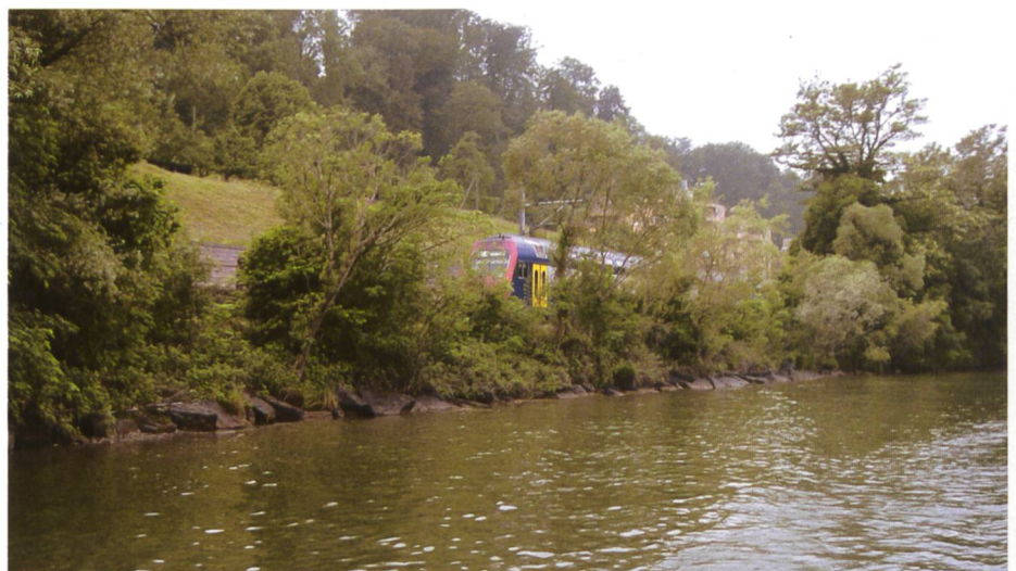
Bil 10. Typisches Erscheinungsbild eines Uferabschnittes des Zürichsees: Die Bahnlinie wurde auf eine Schüttung gebaut. Das neue, steilere Ufer ist mit Blockwurf gesichert. Das Ufer ist für Menschen unzugänglich und deshalb störungsarm. Die Hohlräume im Blockwurf bilden ein Sekundärbiotop, welches Fischen als Kinderstube dient. Der wertvolle Übergangsbereich Land – Wasser ist jedoch praktisch völlig verschwunden (Strecke zwischen Wädenswil und Richterswil).
