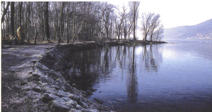
Bilder 3 und 4. Uferrenaturierung in Ipsach am Bielersee. Ein hart verbautes Ufer wird durch Vorschüttungen aufgewertet.
