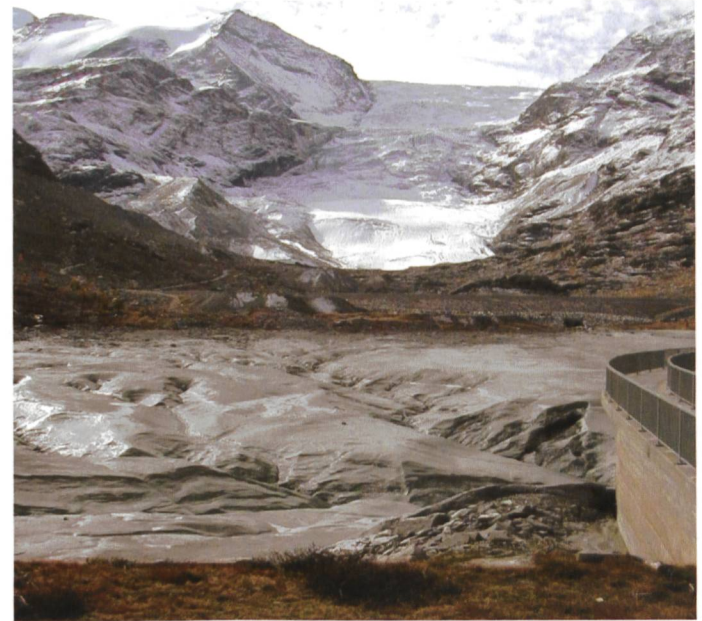
Figure 6. Ensablement du barrage de Tourtemagne.
