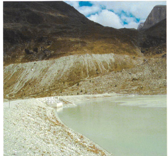
Figure 8. Digue du bassin de décantation avec son déversoir.
