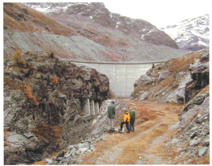
Figure 4. Vue aval du barrage de Tourtemagne.
