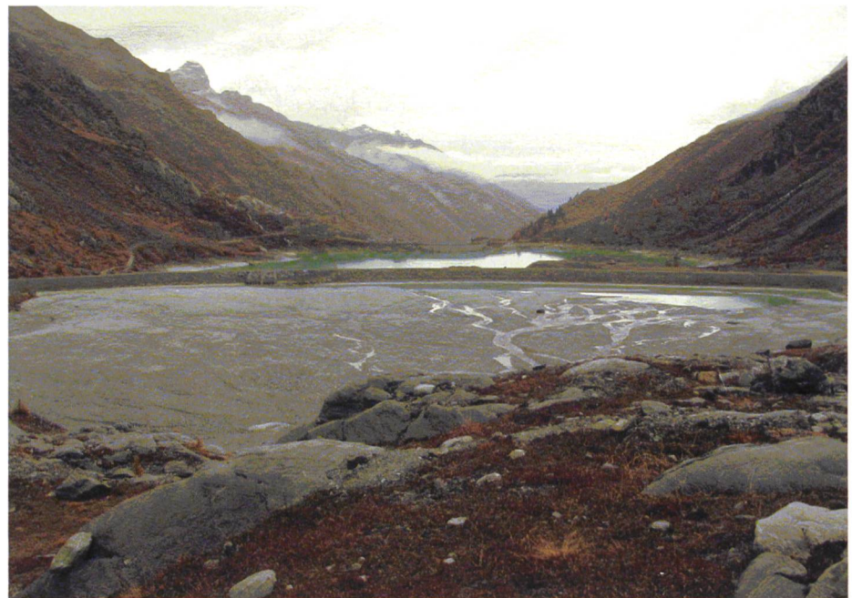
Figure 10. Vue amont du bassin de décantation et du barrage.
