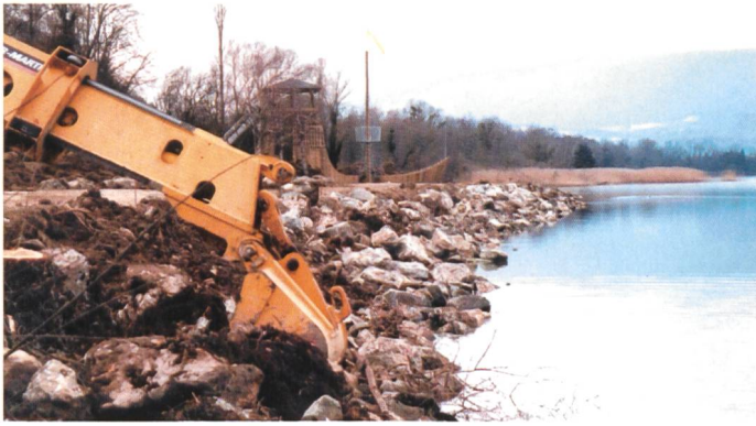
Bild 4. Rückbau eines Blockwurfs (Strandbad Erlach).
