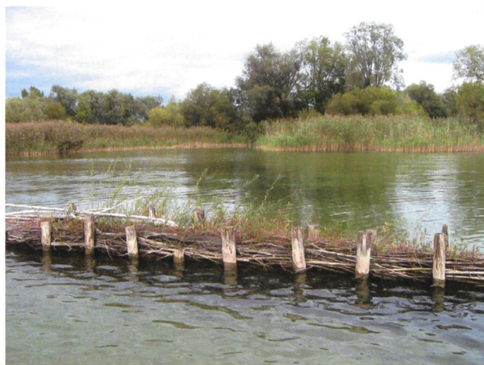
Figure 1. À gauche, érosion linéaire sur la rive nord du Léman; à droite, Protection de rive par des barrages à claire-voie sur le lac de Bièvre.
