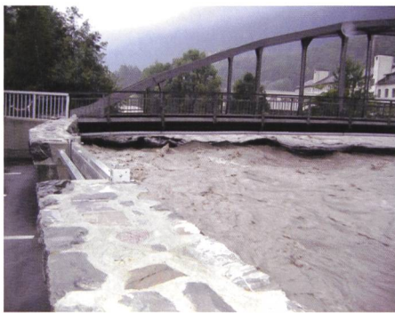
Bild 1. Eleganter Dammbau aus örtlichen Natursteinen mit Öffnung für Schneeräumung, Mitlödi GL. Gebaut durch TBF-Marti AG in Schwanden GL, abgeschottet mit Hochwassersystem Talimex AG.
