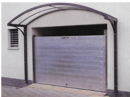
Bild 2. Hochwasserschott bei Eingang Privathaus in Sarnen OW.
