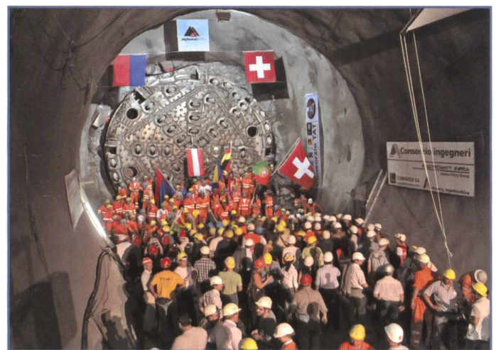
Bild 14. Durchschlag Oströhre in der Multifunktionsstelle Faido.
