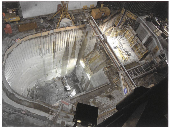
Bild 14. Betonarbeiten im Schacht im Juli 2007.
