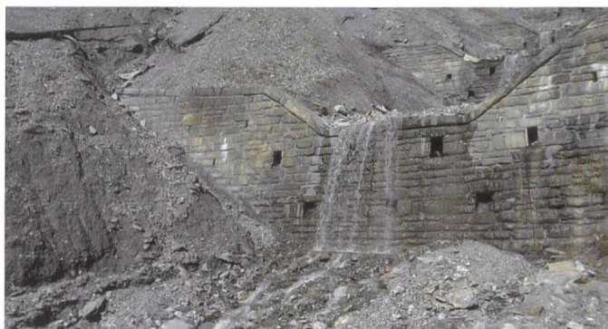
Bild 9. Erosion der seitlichen Flanke durch eine Kombination aus Mechanismus 1A und 3.
