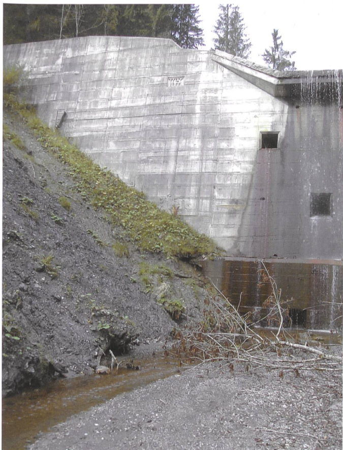
Bild 7. Sohlabsenkung und instabiler Hang infolge Tiefenerosion an einer Konsolidierungssperre.
