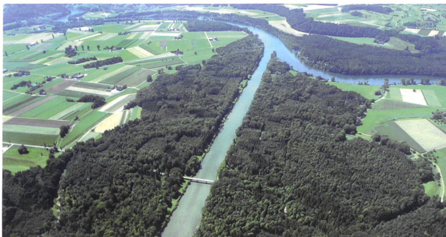
Bild 1a. Die Thur fliesst auf ihrem letzten Abschnitt vor der Mündung in den Rhein in einem begradigten, ökologisch wenig wertvollen und erst noch nicht hochwassersicheren Bett. Sie wird renaturiert und gleichzeitig hochwassersicher gemacht. Die Thur fliesst hier durch das grösste nationale Auenschutzgebiet des Mittellandes, das ebenfalls aufgewertet wird. Im Hintergrund links erkennt man das landwirtschaftlich intensiv genutzte Flaacherfeld.
