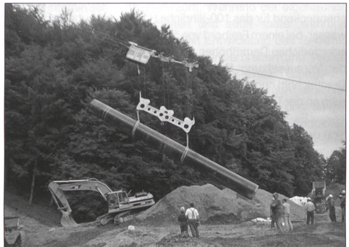
Transport und Versetzen Erdgasleitung, Rohrgewicht 12 Tonnen
