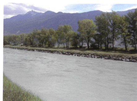
Figure 3. Le Rhône endigué à l'amont de Martigny.
