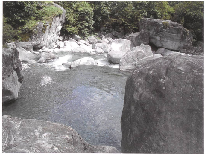
Figure 16. Rivière à poissons construite de façon «naturelle».
