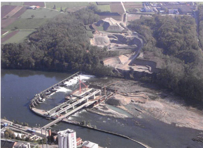
Bild 29. Zufahrt Baustelle von Schweizer Seite hergestellt.
