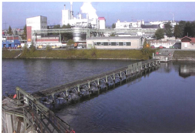
Bild 4. Rückbau alter Grobrechen am Oberwasser-Kanaleinlauf.
