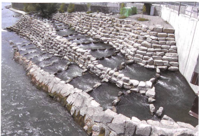
Bild 25. Neuer Raugerinnebeckenfischpass an der bestehenden Kanalmauer.
