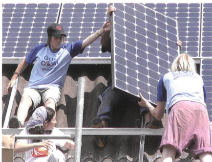
Bild 1. Montage von Solaranlagen in Ruswil.
