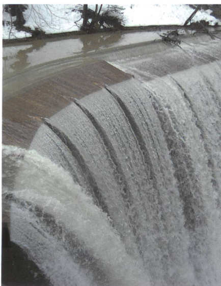
Bild 2. Überfall-Staumauer bei Hochwasser (Detail).
