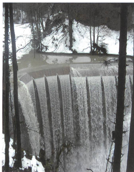
Bild 3. Überfall-Staumauer bei Hochwasser.
