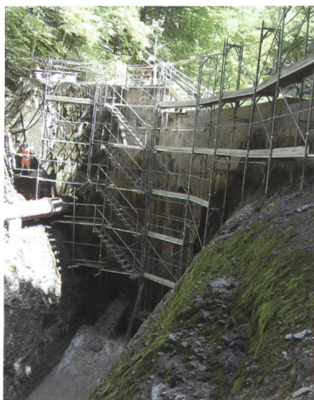
Bild 1. Sanierung Staumauer mit Druckleitung und Grundablass.
