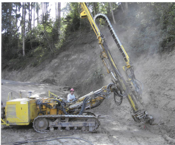
Bild 15. Bohrarbeiten für Injektionen im linken Widerlager.
