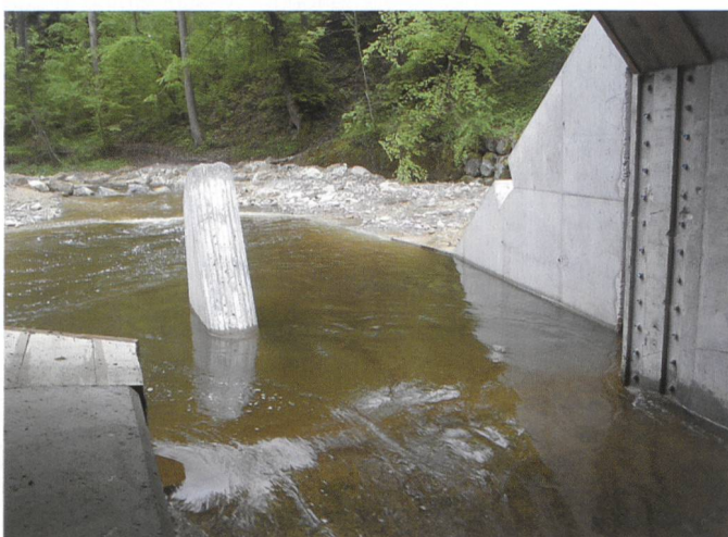
Bild 4. Einlaufbereich zum Durchlass im Bauzustand ohne Frontplatte und Drosselblende.
