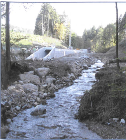
Bild 11. Baumleitung mit Durchlassbauwerk im Oktober 2005.
