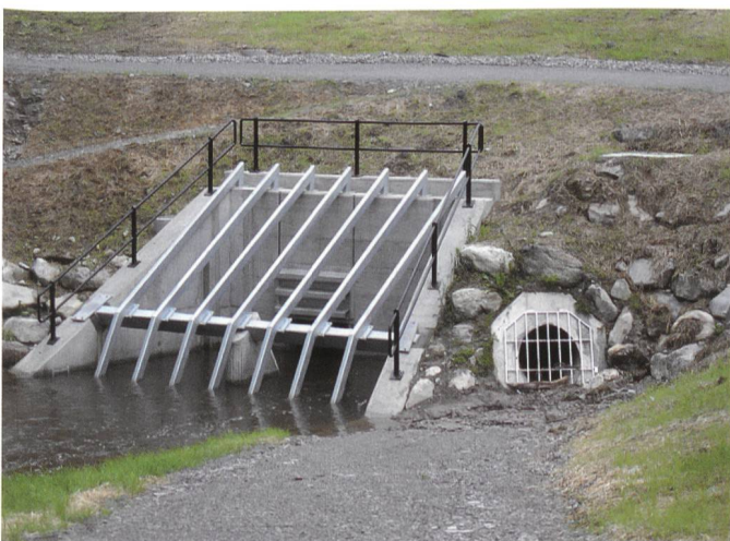
Bild 7. Einlaufbauwerk mit Drosselöffnung und vorgelagertem Tauchrechen. Die Einlauföffnung der Notentleerung ist rechts angeordnet.
