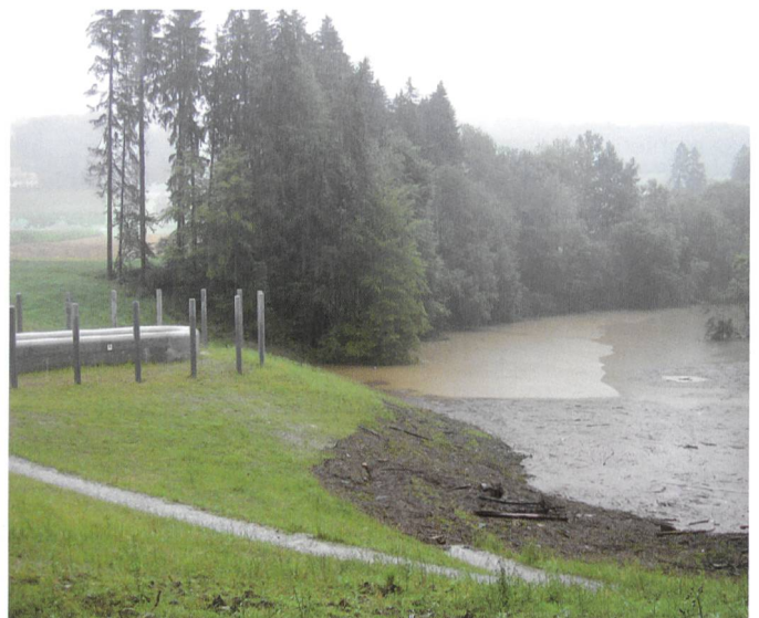
Bild 16. Ersteinstau des Hochwasserrückhaltebeckens am 9. August 2007.
