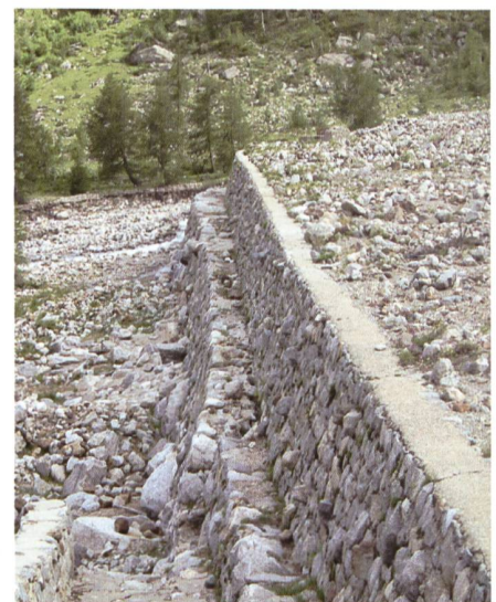
Bild 2. Kiesfang vor der Mündung des Palübaches in den Palüsee.
