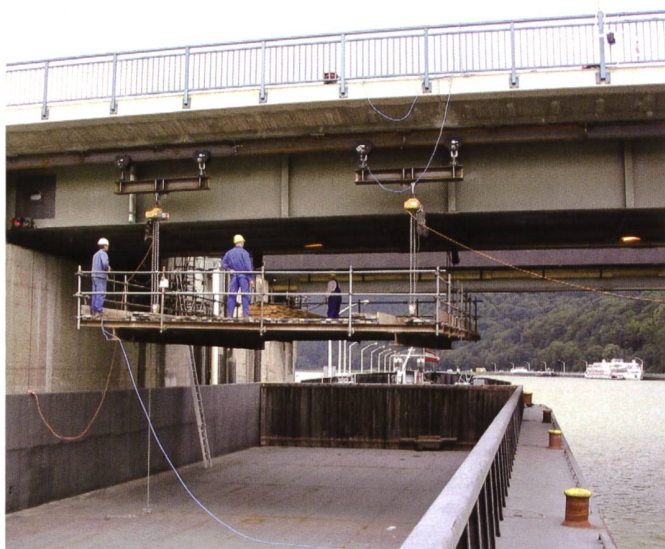
Bild 8. Ausheben des Hängegerüsts aus dem Schwimmponton.
