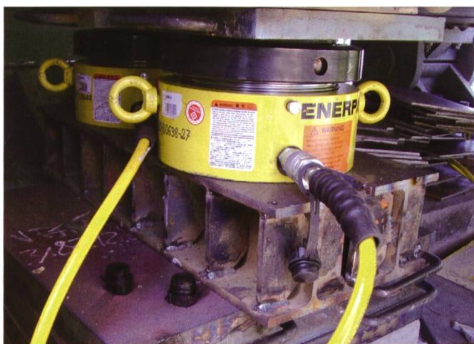
Bild 10. Heben der Kranbahnträger.
