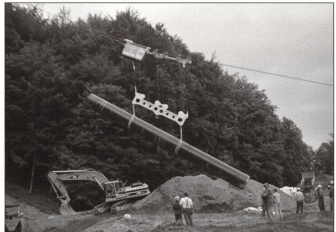
Transport und Versetzen Erdgasleitung, Rohrgewicht 12 Tonnen
