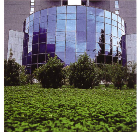
Bild 1. Das TIS-convention-center in Bozen, Italien.
