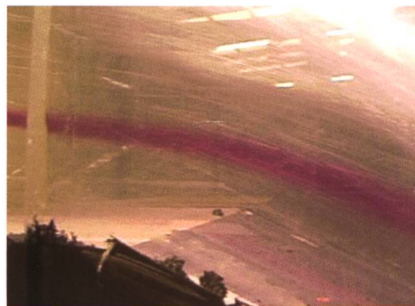
Bild 2. Schäden durch Unterdruck beim Schwellenknick. Fliessrichtung von links nach rechts, Aufnahme zu Beginn der Trockenarbeiten beim Wehrfeld 1.
