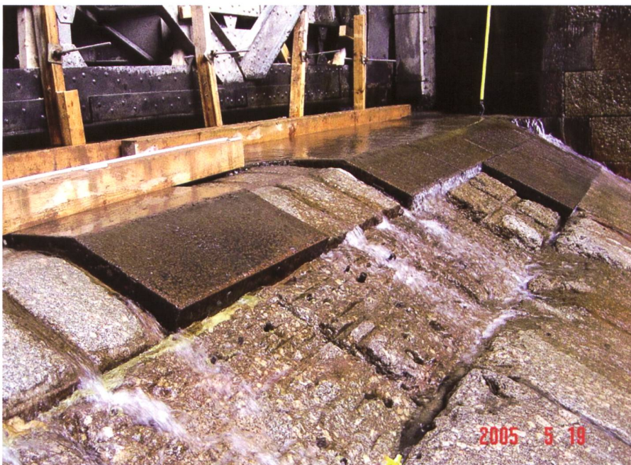
Bild 2. Schäden durch Unterdruck beim Schwellenknick. Fliessrichtung von links nach rechts, Aufnahme zu Beginn der Trockenarbeiten beim Wehrfeld 1.
