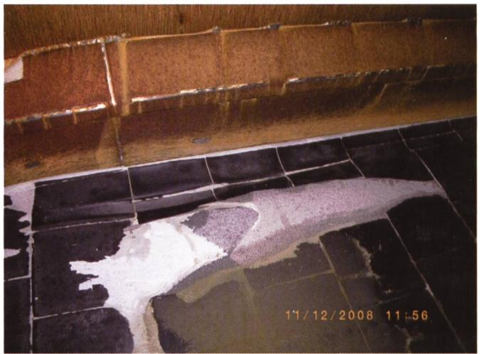
**Bild 4. massiver Verschleiss an aufwändiger Basaltpanzerung.**
