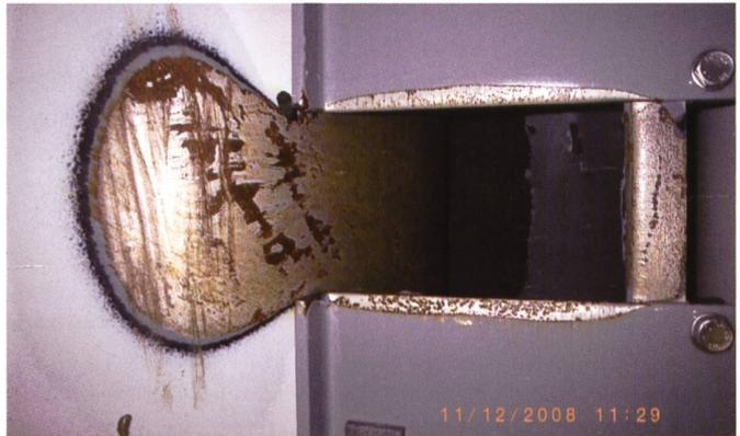
**Bild 5. Verschleiss des Korrosionsschutzes am Abzugrohr System HSR.**
