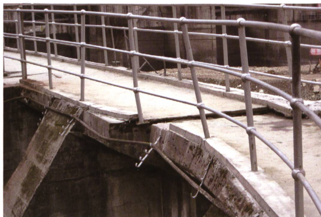
Bild 8. Yingxiuwan: Differentielle Bewegungen an Gehstegfugen.
