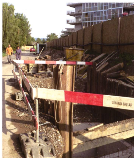
Bild 2. Abwasserwärmanlage Wässerwiesen Winterthur, Bauarbeiten Abwasserkanal, September 2009.
