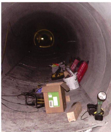
Bild 3. Abwasserwärmanlage Wässerwiesen Winterthur, Abwasserkanal mit Wärmetauscherelementen, September 2009.
