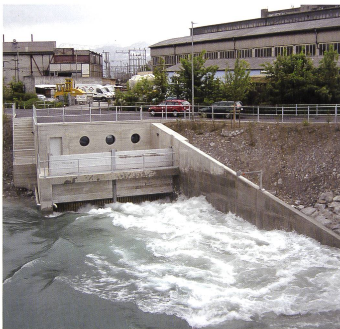
Bild 6. Auslaufbauwerk bei einem Ausfluss aus dem Stollen von knapp 90 m³/sec während der ersten Tests (Quelle: IC).
