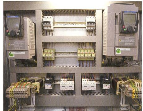
**Bild 3. Der Schaltschrank mit der neu installierten Frequenzumrichter-Steuerung.**
