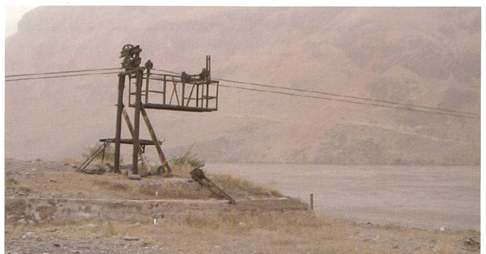
Bild 37. Khirmandschu – Abfluss-Messstation am Pyandj, ausser Funktion, mit Blick nach Afghanistan.
