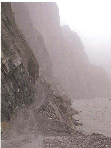
Bild 11. Einzige, ganzjährig offene Strassenverbindung zwischen West- und Ost-Tadschikistan 2003, vor dem Ausbau. Fluss: Pyandj.
