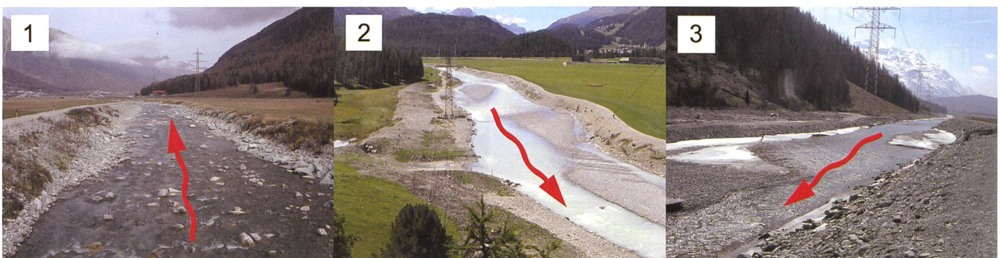
Bild 2. Drei charakteristische Abschnitte des neuen Flazgerinnes: 1. Makrorauigkeiten, 2. Aufweitung (VAW Web-Cam) und 3. Alternierende Bänke.
