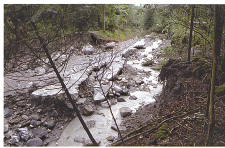
Bild 5. Dürrenbach. Zerstörte Bachschale. Blick in Fliessrichtung. (Foto Bänziger Partner AG).
