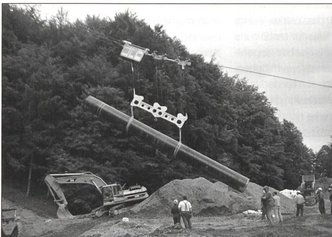
Transport und Versetzen Erdgasleitung, Rohrgewicht 12 Tonnen
