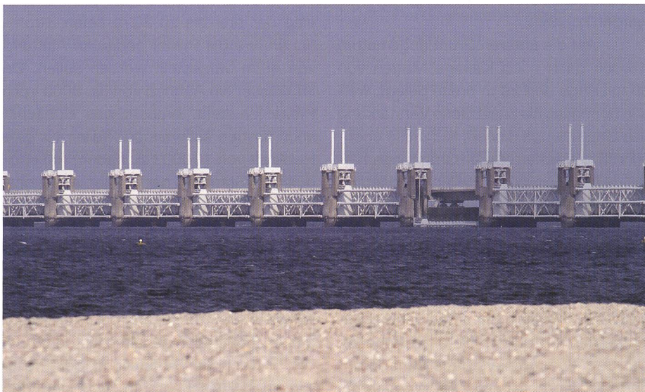
Bild 18. Oosterscheldedam mit einer wegen Unterhaltsarbeiten geschlossenen Stahlschütze.
