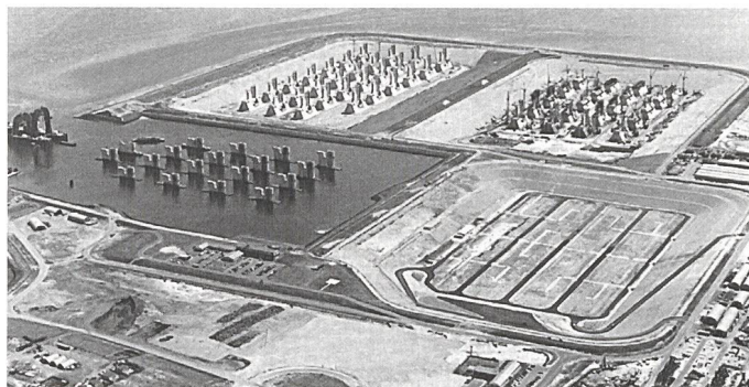
Bild 16. Die Baugrube Schaar mit den vier Docks.
