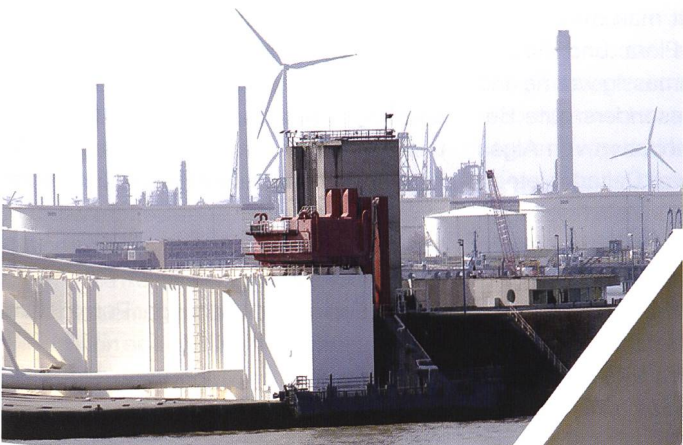
Bild 21. Eines der beiden Lokomobilen (rote Konstruktion).
