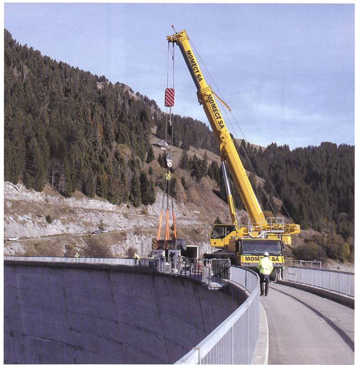
Bild 7. Am 29. Oktober 2009 wurde ein Hubversuch mit 28 t auf der Staumauer Nord gemacht, der die theoretischen Konzepte in situ bestätigte.
