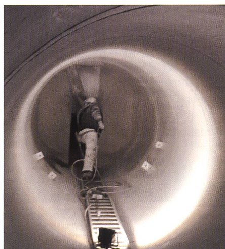
Bild 9. Die Korrosionsschutzarbeiten an der Stahlpanzerung unterhalb der Schieber.
