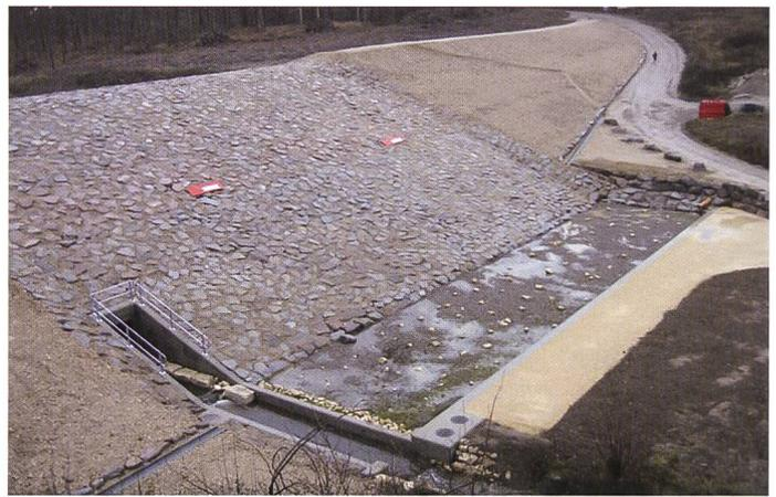
**Bild 9. Hochwasserentlastung, Auslauf Durchlass und Tosbecken.**
