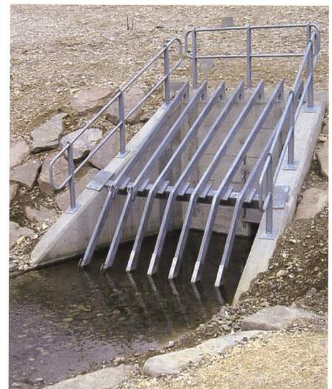
**Bild 7. Einlaufbauwerk mit Drosselöffnung und Grobrechen.**
