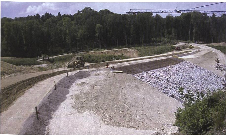
**Bild 5. Draufsicht auf Damm mit erkennbaren Dammmzonen.**
