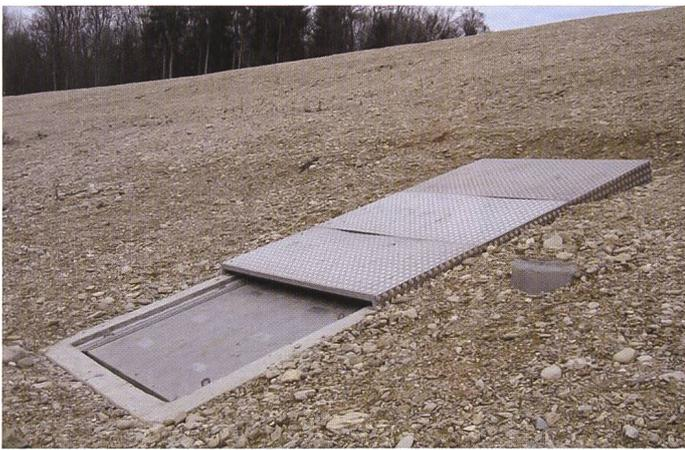
**Bild 8. Notentlastung mit Tafelschieber.**
