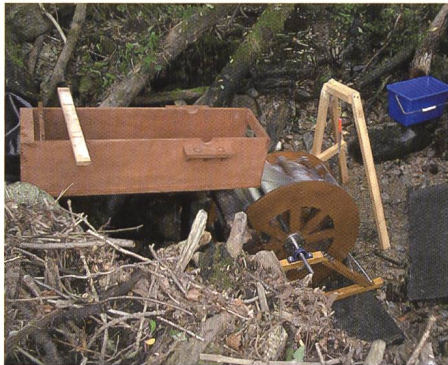
Bild 8.8. Das Rad wird installiert.
