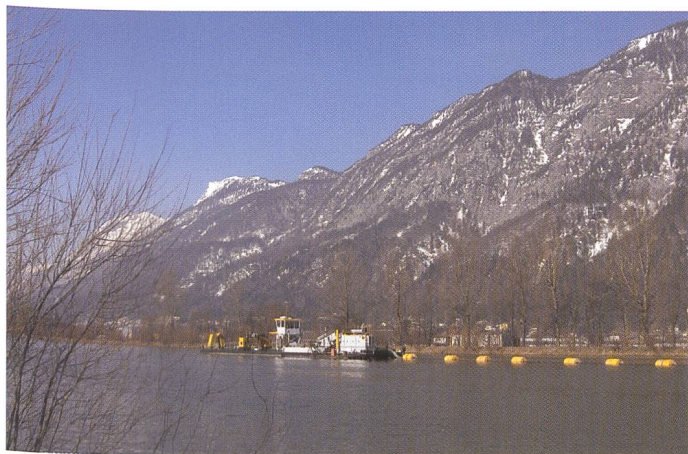
Der Saugbagger «Vecht» beim Einsatz in den österreichischen Alpen, (Foto: Geluk).
