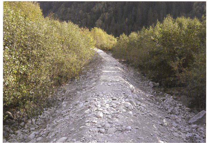
Bild 3. Geschiebedotierung 2009. Links, Laster bringt Geschiebe unterhalb des heutigen Geschiebesammlers ein, rechts, mit Geschiebe dotierte Sohle des Gadmerwassers direkt unterhalb des Geschiebesammlers – bereits einen Monat später hat ein kleineres Hochwasser das deponierte Material vollständig abgetragen.
