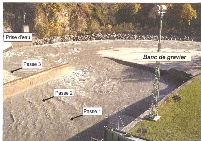
Figure 3. Etat alluvionné observé lors de la purge du 28 octobre 2005 (vue de l'aval, rive gauche).
