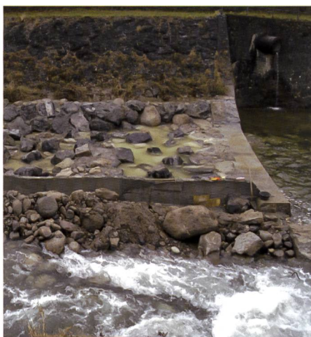
fig. 9, 10 et 11. Réalisation de la rampe au droit du seuil de Valacrêt à Moudon, coordonnées: 550 400/167 300.
