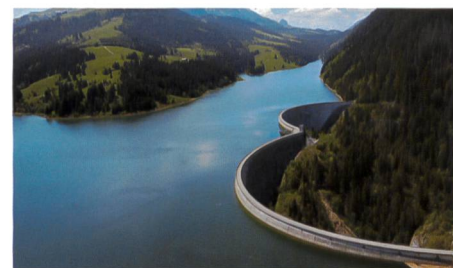
Bild: Bogenmauer Hongrin der FMHL.
