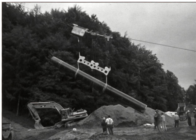
Transport und Versetzen Erdgasleitung, Rohrgewicht 12 Tonnen
