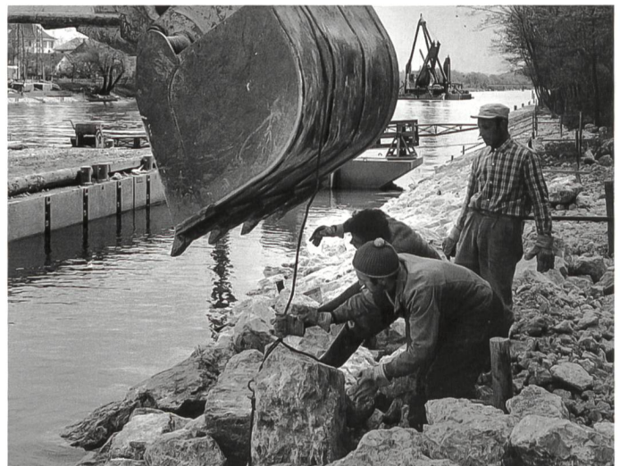
Bild 9. Steinwüste oder Uferschutz: Uferausbau während der Zweiten Juragewässerkorrektur. (archiv suzanne muller).
