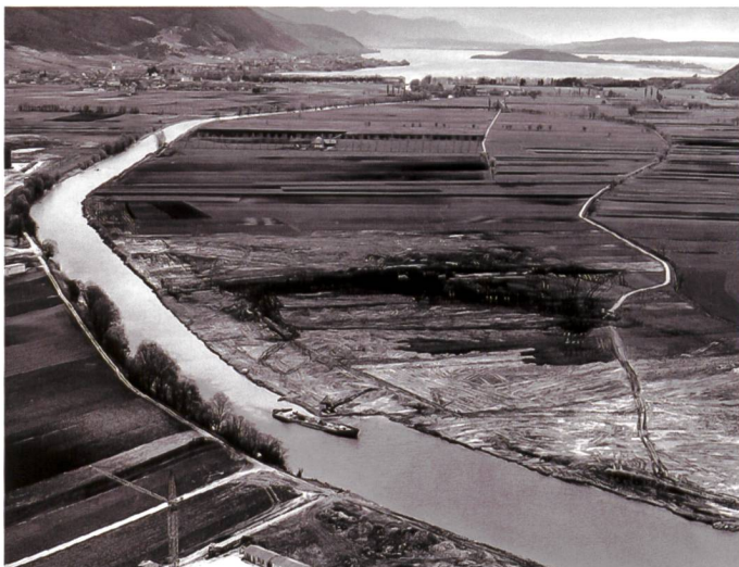
Bild 8. Verbreiterung des Zihlkanals zwischen Neuenburger- und Bielersee (oben) während der Zweiten Juragewässerkorrektur. (archiv suzanne muller).
