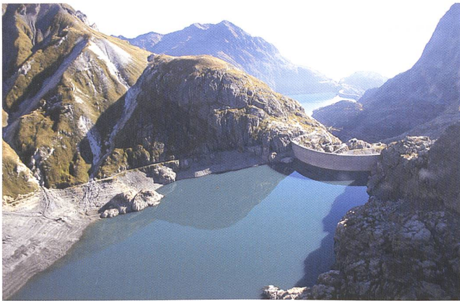
Bild 4. PSW können überall dort realisiert werden, wo zwei Speicher auf unterschiedlicher Höhe liegen (im Bild: Vieux-Emosson und Emosson, Foto: Alpiq).
