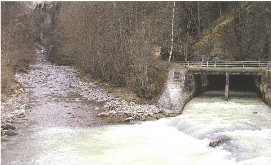
Bild 3. Unteres Gadmerwasser bei der Wasserrückgabe vom Kraftwerk Innertkirchen 1. Mit der künftigen Verlegung der Wasserrückgabe (unter dem Gadmerwasser hindurch) und einer weiteren Erhöhung der Restwassermenge steht dieser Gewässerabschnitt (links im Bild) künftig als Laichstrecke für die Seeforelle wieder zur Verfügung.
