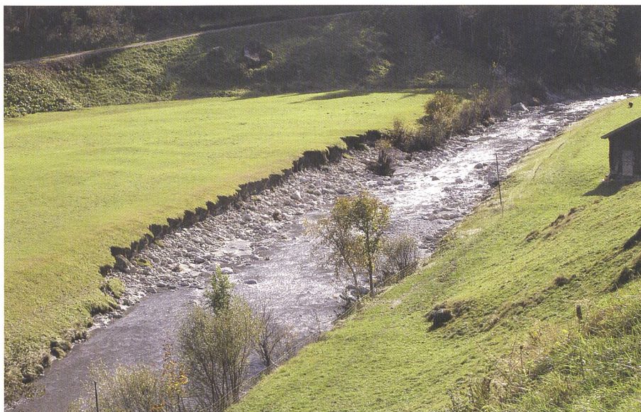
Bild 4. Ansicht auf den unteren Abschnitt der künftigen Flussrevitalisierung Fuhren-Süd. Das Hochwasser vom 10.10.2011 hat bereits erste ökologische Arbeiten in diesem Abschnitt vorweggenommen.
